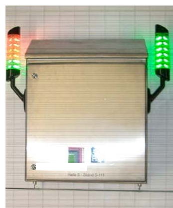
無塵室警示燈 + 無塵室不銹鋼開關箱
