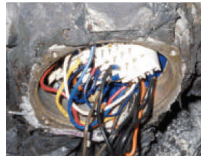
火災後檢查內部設備未燒毀
